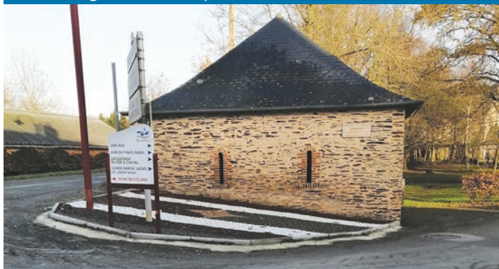
Aménagement du parterre de l'abribus
